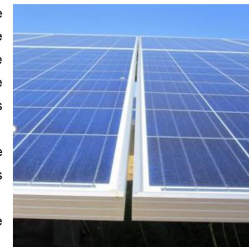
Les installations de panneaux n'imperméabilisent pas le sol : surface couverte limitée à 42,3 % du site, inclinaison qui permet à l'eau de s'écouler. Sur le parc de la Pouge, d'une surface totale de 20,31 ha, la surface horizontale recouverte par les modules sera de l'ordre de 8,6 ha.
